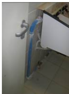
Foto 10 B: Ângulo de profundidade
